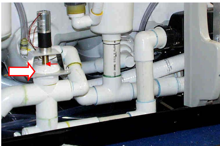
Pumpe 1 (neben Heizung)
